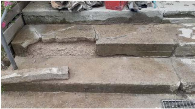
*Frostschäden an der Eingangstreppe; Foto: M. B.*
