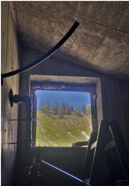
Hüttenwart in der Grube mit guter Aussicht: Inspektion der Quellfassung. Foto: P.S.
