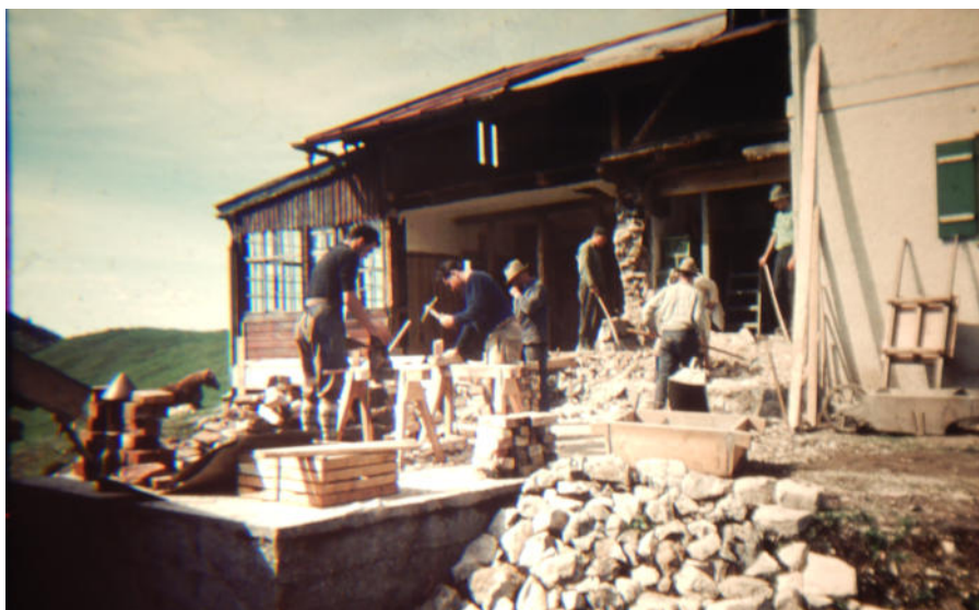
Umbauarbeiten auf dem Bodenschneidhaus Anfang der 1960er Jahre. Foto: H.L.
