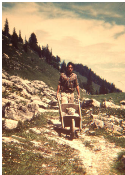
Heinz Lehner bei Umbauarbeiten am Bodenschneidhaus Anfang der 1960er Jahre. Foto: H.L.
